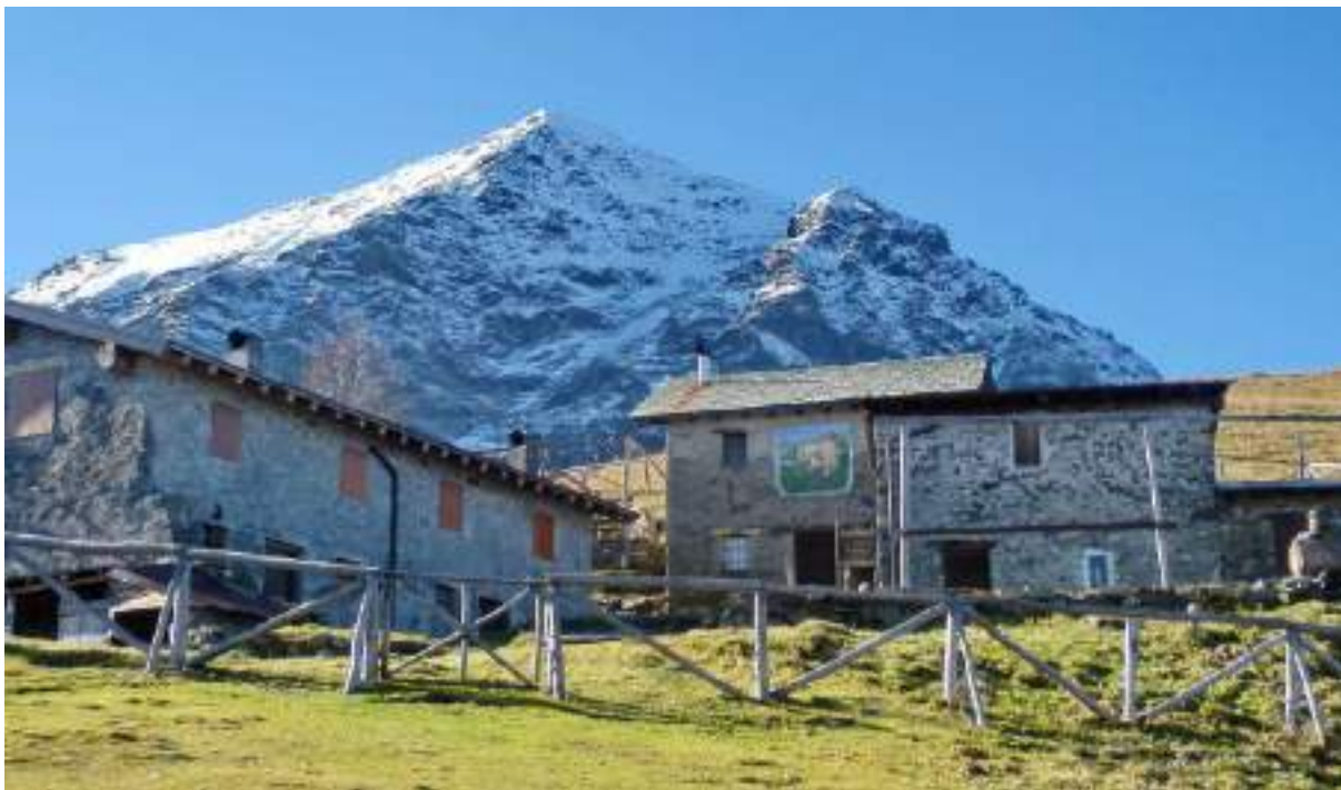
Itinerario T.O.2: Il rifugio Legnone, tratto E.
