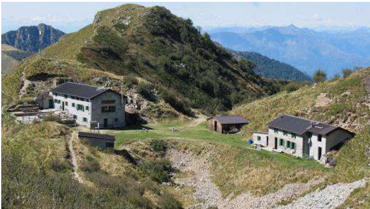
Itinerario T.O.4: Il rifugio Santa Rita, tratto C.
