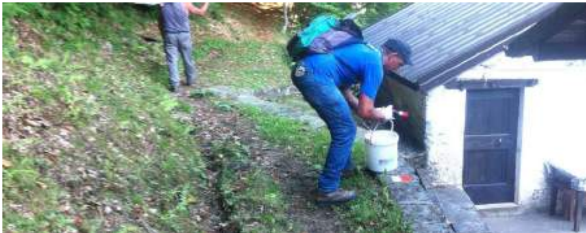
Immagine realizzazione di segnaletica orizzontale
