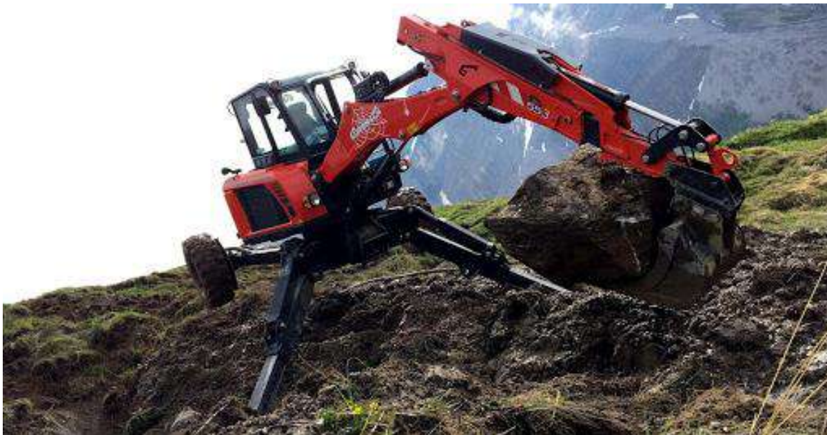
Escavatore tipo ragno, necessario per la realizzazione delle lavorazioni più complesse in alta quota.
