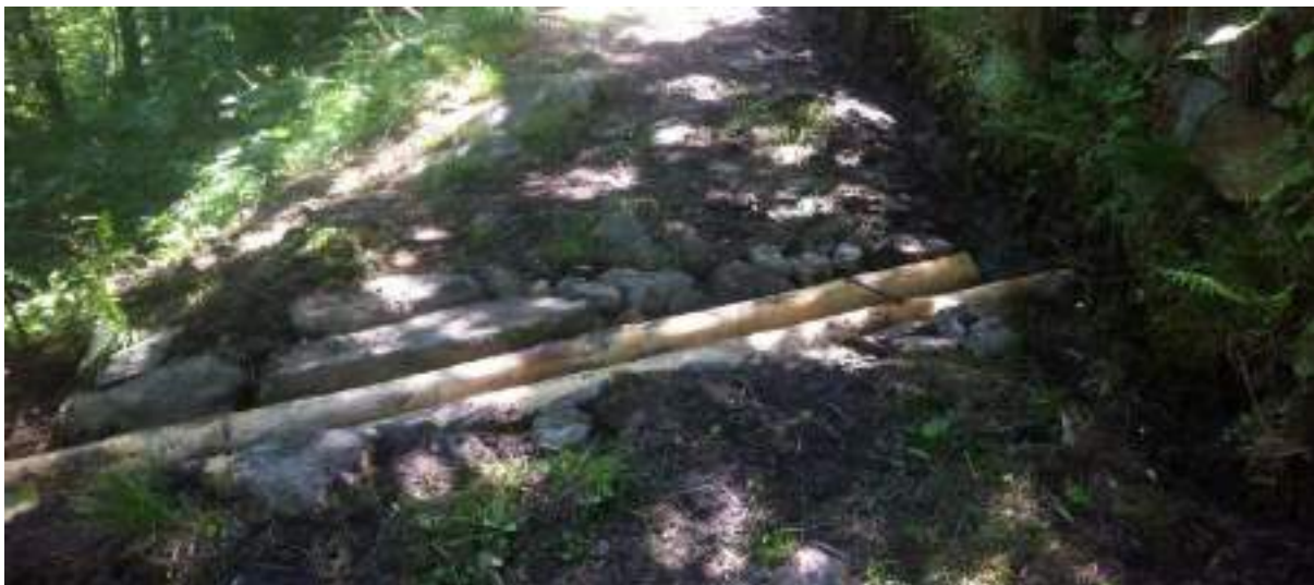
Esempio immagine realizzazione canaletta di scolo
