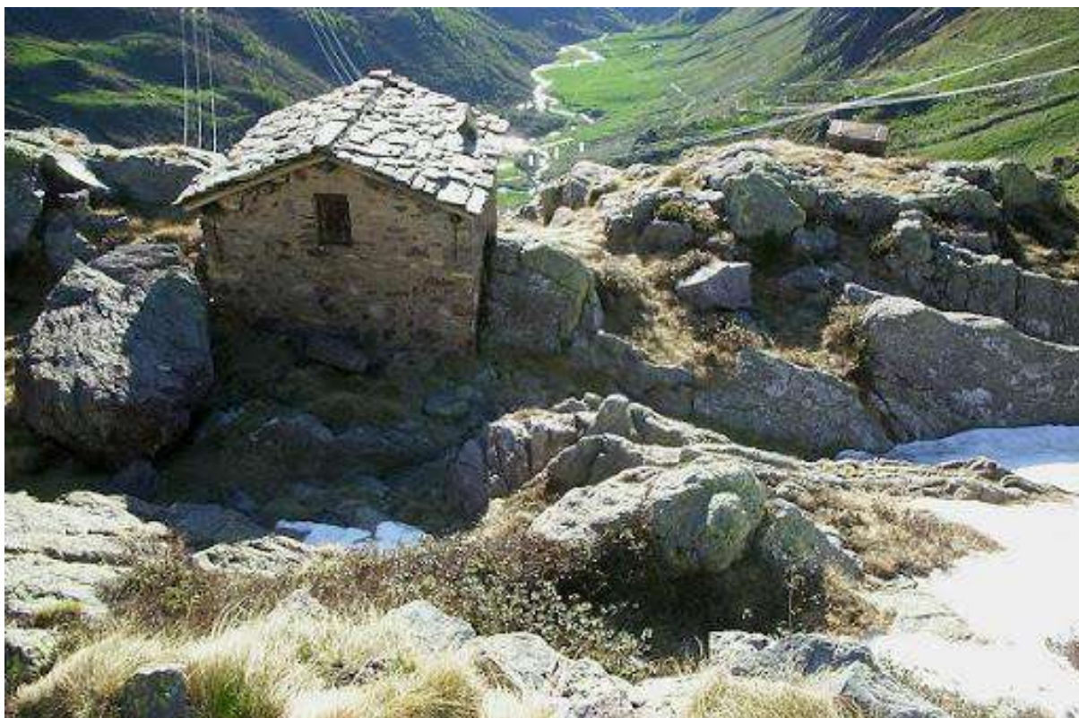
Itinerario T.O.4: tratto D.
