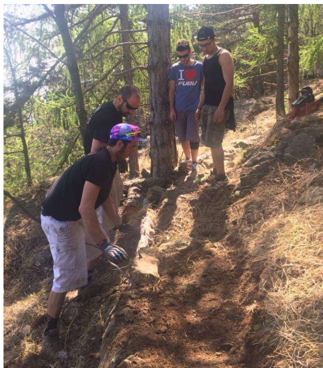
Esempio immagine rimodellamento del fondo sentieristico su terreno
