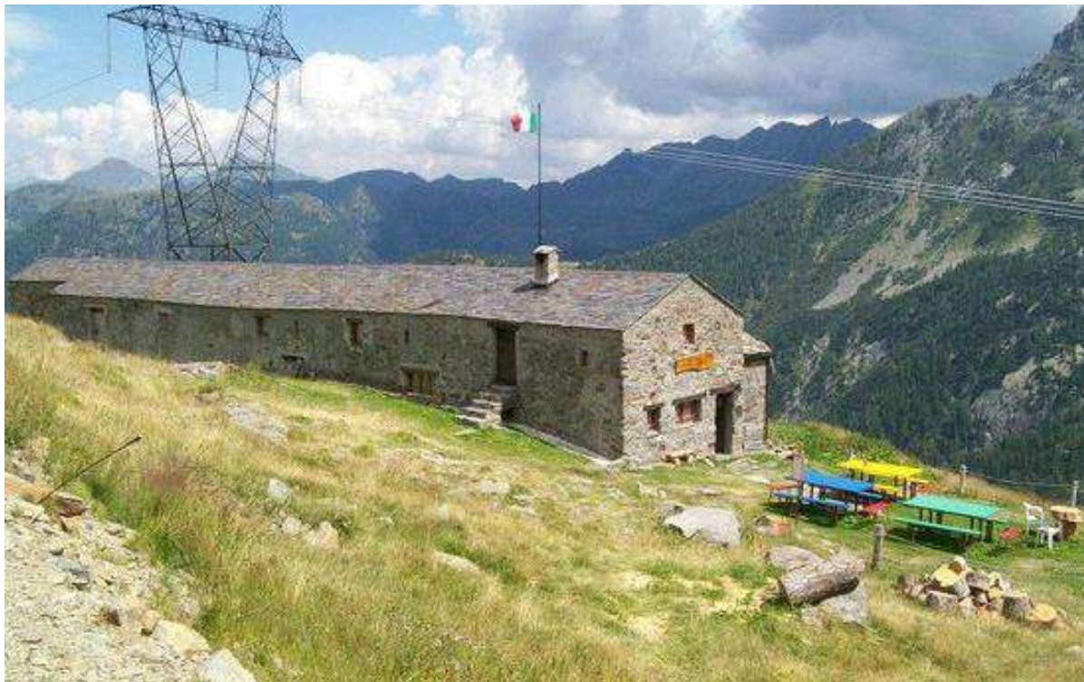
Itinerario T.O.4: Il rifugio di Trona Soliva, tratto F.
