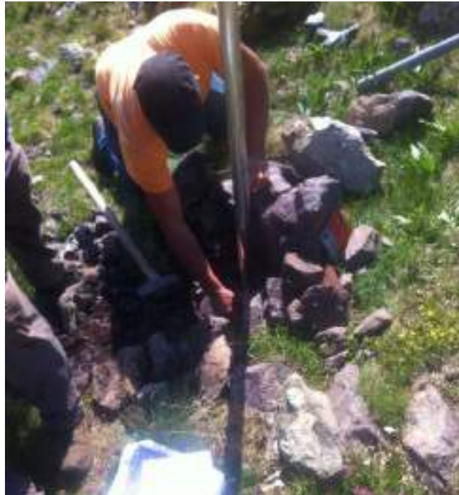
Immagine collocazione di palo per la segnaletica verticale
